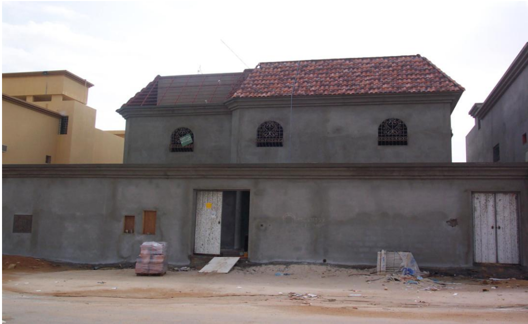
شكل 18. صورة تبين بروز في سقف الدور الأول على شكل كورنيش تم وضعه لعمل القرميد المائل حوالي السترة.
