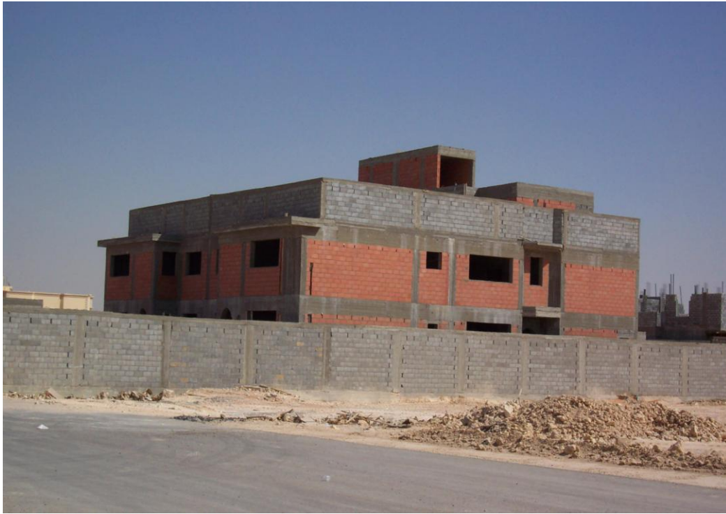
شكل 17. صورة تبين بروز في سقف الدور الأول لحمل القرميد المائل حوالي السترة.
