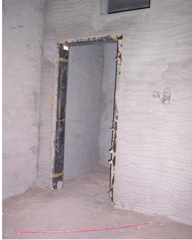
شكل 11. صورة لحلق باب داخلي عرض 24سم مركب على حائط داخلي عرض 24سم.
