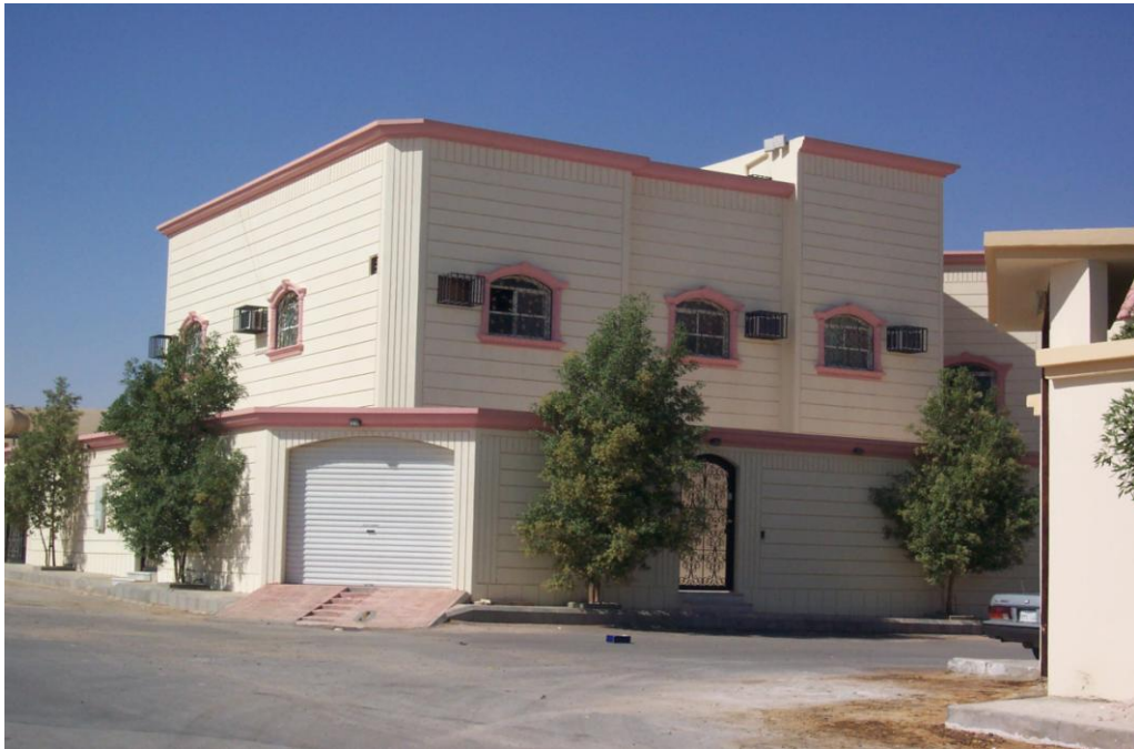
شكل 15. صورة تبين نوافذ الدور الأول ذات الأعتاب المقوسة وعليها حديد حماية.
