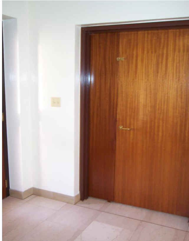
شكل 12. صورة لباب داخلي بحلق عرض 15سم مركب على حائط داخلي عرض 24سم تبين الفرق الذي يستغل عادة من المنجرة.
